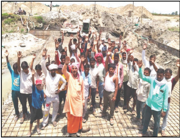
जिला मुख्यालय से दूर और बाढ़ प्रभावित है। पहले यहाँ 30 मीटर लंबी पुलिया थी, जिसे तोड़कर अब केवल 15 मीटर लंबी पुलिया बनाई जा रही है।
